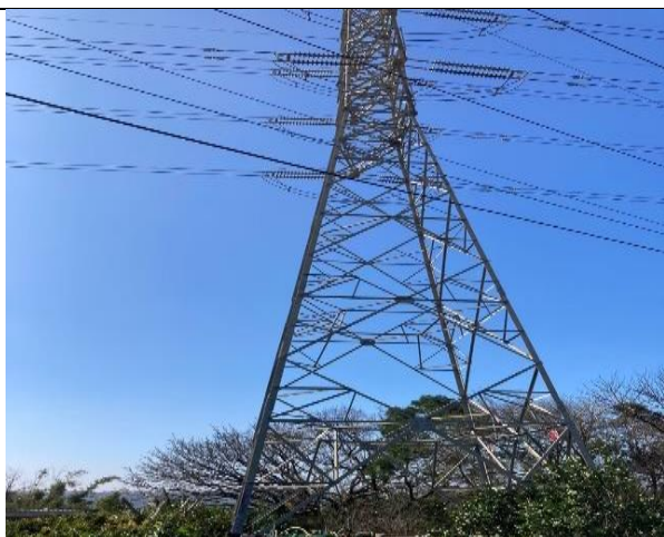
建地 DA-2/2 外埔區水美南段 1045 地號
