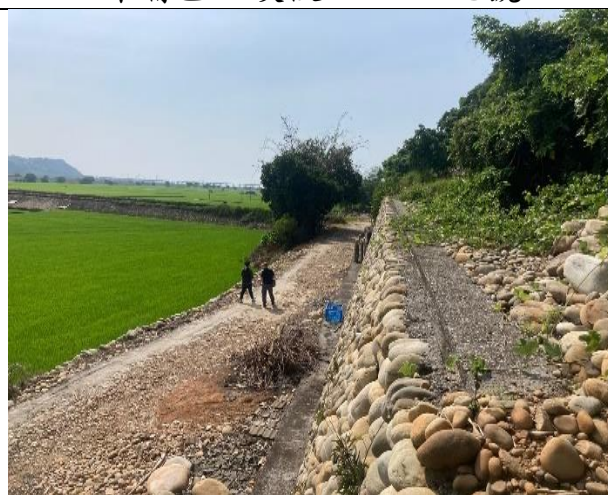
道路 DC-1/2 后里區口庄段 685 地號內
