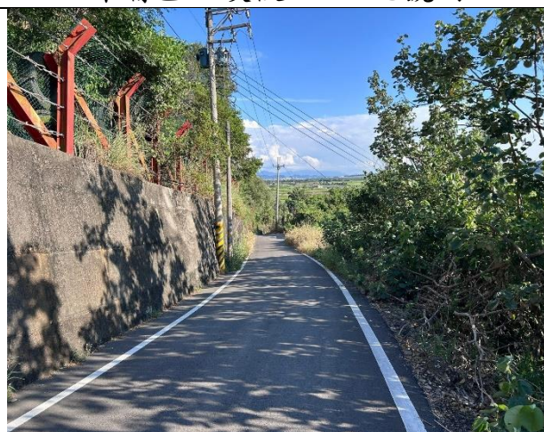
道路 DB-4/4 外埔區三崁段 1069 地號內
