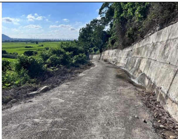
道路 DB-1/4 外埔區三崁段 1268 地號內
