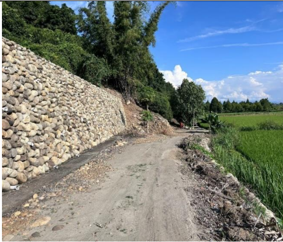
道路 DC-2/2 后里區口庄段 690 地號內
