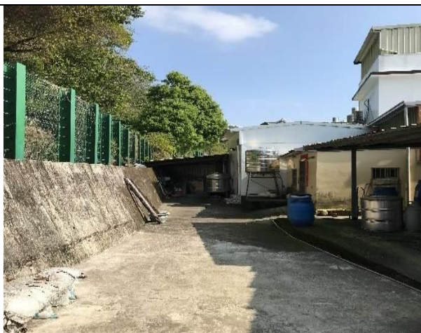
建地 CB 外埔區水美南段 1027 地號內
